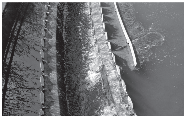
二沉池出水堰
